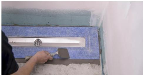
Instalar la rejilla de acuerdo con el acabado al gusto: acero inoxidable, cerámica o piedra natural. Pegar los recubrimientos sobre la rejilla utilizando el adhesivo sellador MS 6. Rejuntar con el mortero para juntas Multifuge Diamond.
