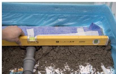
Una vez fraguado el mortero, conectar el cuerpo del desagüe al sistema de drenaje del edificio. Asegurarse que la tubería tenga suficiente pendiente y que no haya fugas de agua. Se recomienda verter agua en el sistema de desagüe para comprobar que se ha hecho un montaje correcto.
