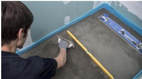
Enseguida, impermeabilizar toda la zona de la ducha, incluyendo las paredes, utilizando la lámina impermeable MC-Plan 307 SD o la membrana impermeable MC-Proof 900.
